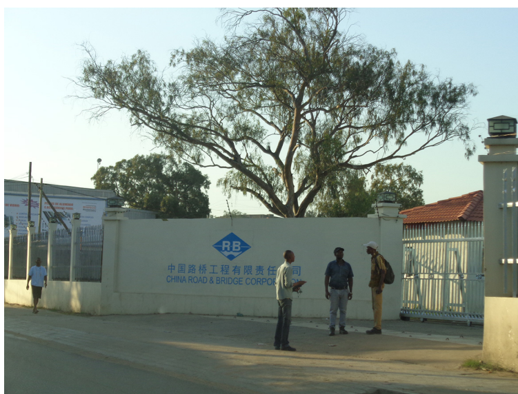
Figure 3 : Chantier du pont de Catembe et camps de travailleurs chinois (cliché : F. Folio, 2016)
