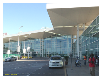
L'aéroport international de Maputo rénové en 2012.
