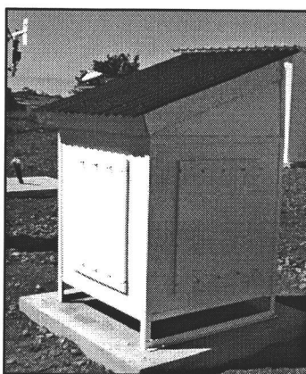
Figure 5: la cellule expérimentale Isotest sur sa dalle en béton
