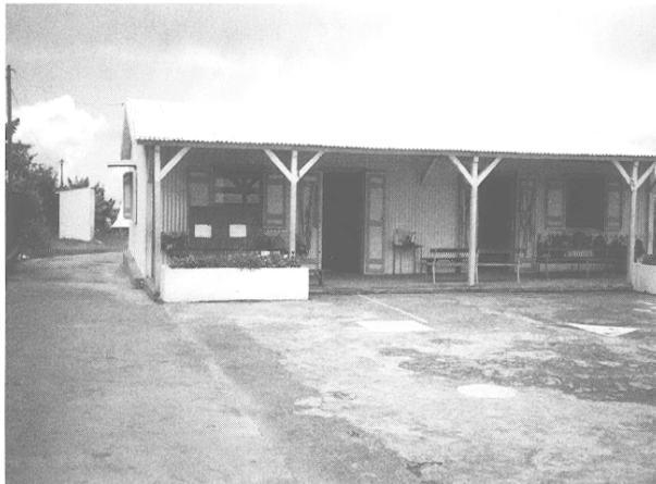
École en bois sous tôle.
