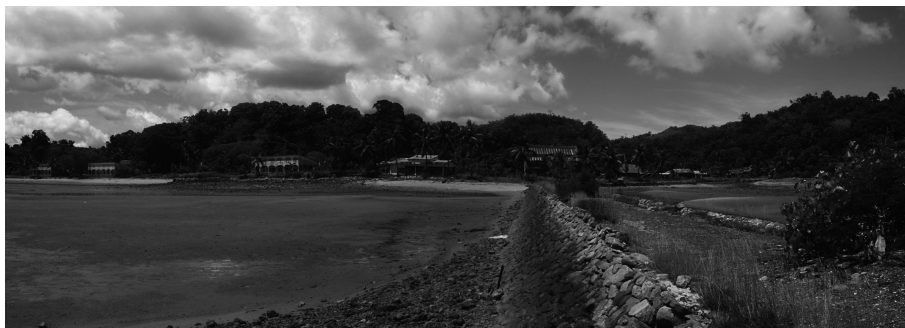
FIGURE 10 : LA JETÉE ET VUE GÉNÉRALE D'AMBANORO
