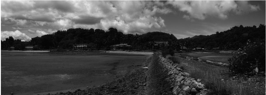
FIGURE 10 : LA JETÉE ET VUE GÉNÉRALE D'AMBANORO
