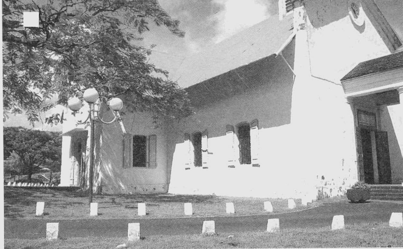
Sainte-Marie, façades nord et est de l'église, 2000, cliché de l'auteur.
