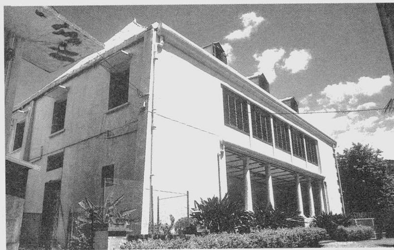
Saint-Denis, façade de la cure, 2000, cliché de l'auteur.
