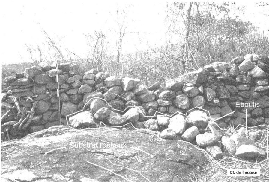
Maçonnerie en pierre sèche (manda d'Erimoho)
