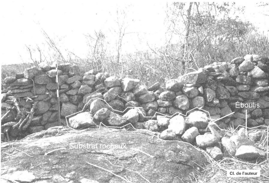
Maçonnerie en pierre sèche (manda d'Erimoho)
