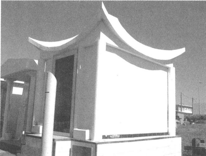
La Réunion, Saint-Pierre, cimetière marin: un caveau moderne qui adopte une architecture sinisante avec ses angles retroussés (deuxième moitié du XX e siècle)
