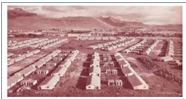
Photo 2 : Constructions à Cité Vallijee en 1967 727
