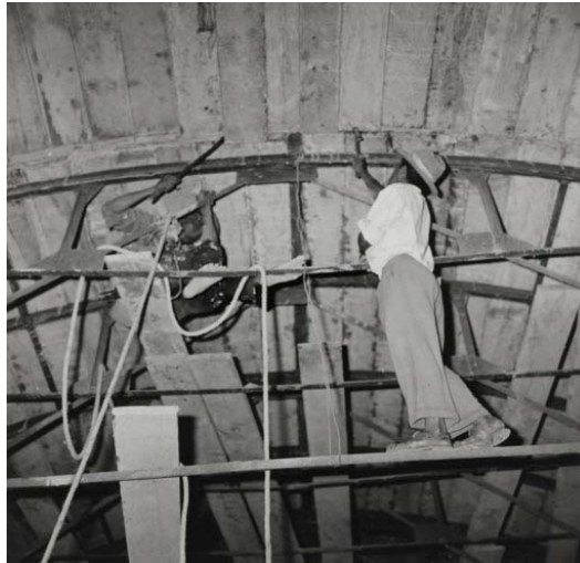
Les « Equipements collectifs » comme la gare de Tananarive construite de 1908 à 1910 par Fauchard.
