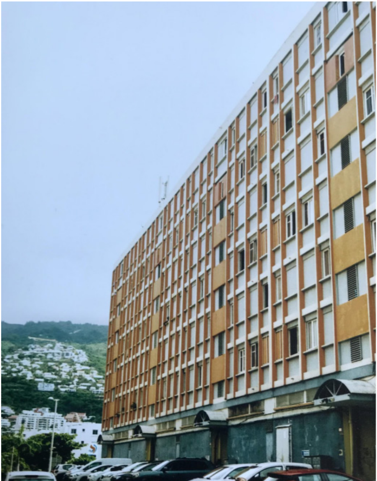
Un des immeubles du quartier Vauban concerné par une démolition (Source personnelle, 2020).
