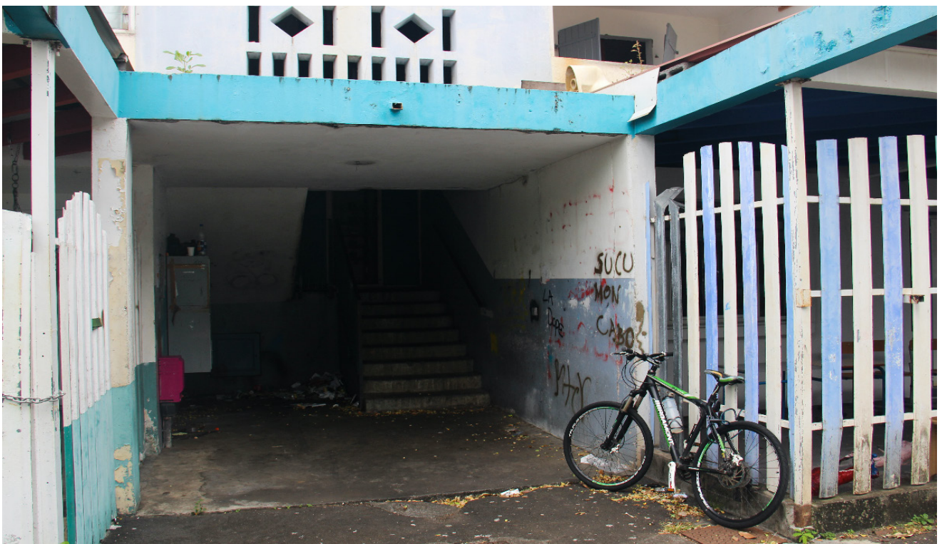
Un des immeubles du quartier du Butor concerné par une démolition (Sources personnelles, 2020).
