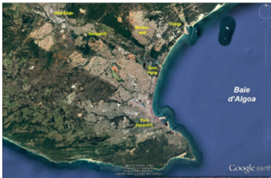
Figure 2 – Extraction Google Earth situant le bipôle portuaire de la baie d'Algoa dans son environnement urbain
