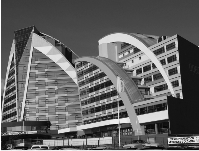
15 – Les « voiles » de l'immeuble Cadjee au Chaudron, Saint-Denis – J.M. Jauze
