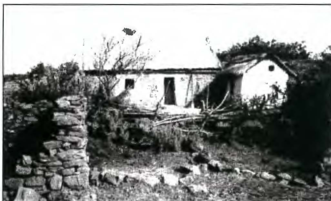
Photo 2 : Un exemple d'habitation en moyenne montagne. Porte et fenêtres sont étriquées pour se protéger du vent et du froid.
