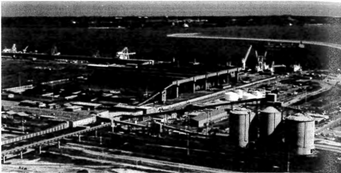
Figure 9 : Vue sur le terminal de vracs solides
