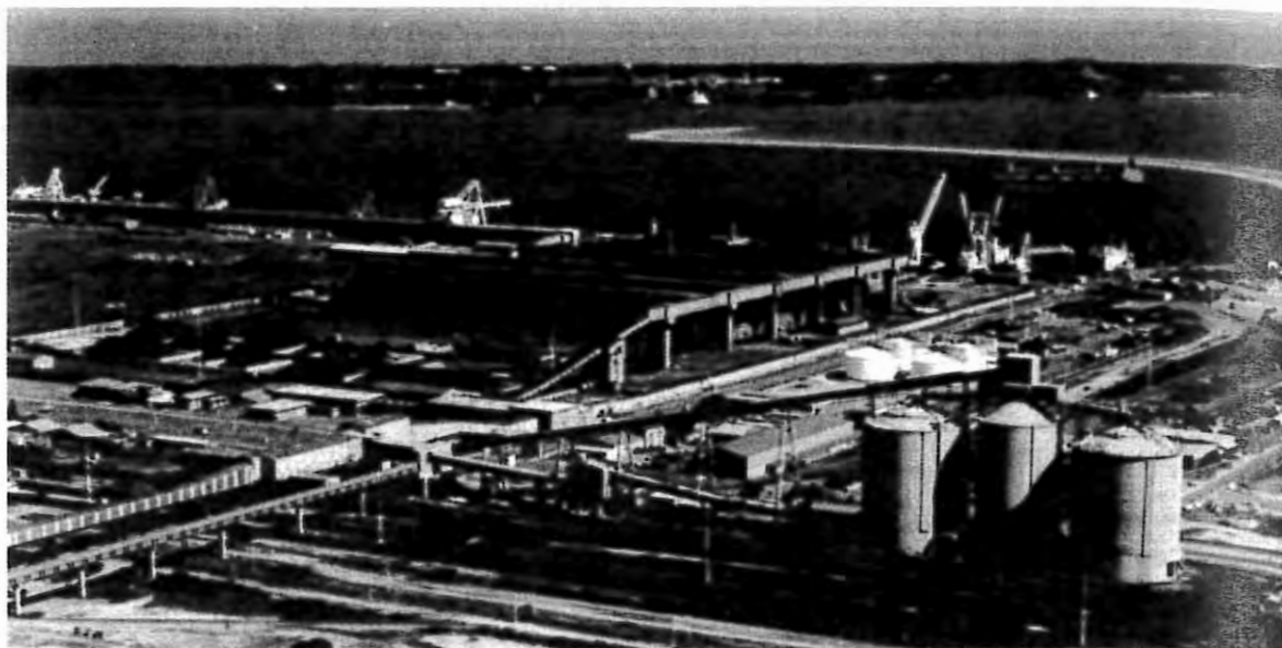
Figure 9 : Vue sur le terminal de vrac solides
