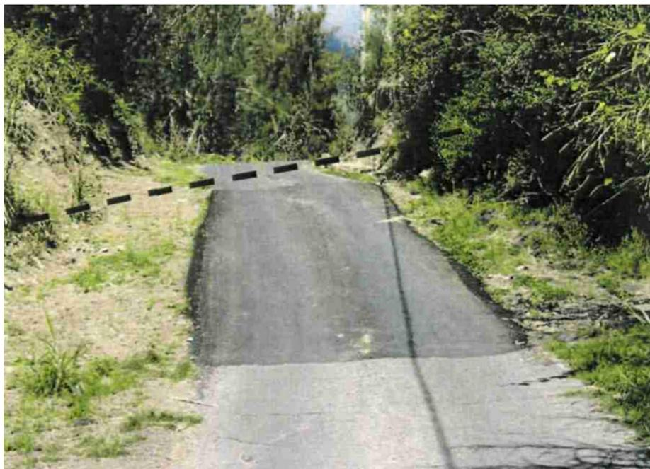
Figure 4: Déformation du chemin en béton reliant la RD48 et le Fond de Rond-Point, dans le glissement de Mare à Poule d'Eau. Le rejet vertical est métrique. Photo correspondant à la Figure 20 de Garnier et Lucas, 2008.
