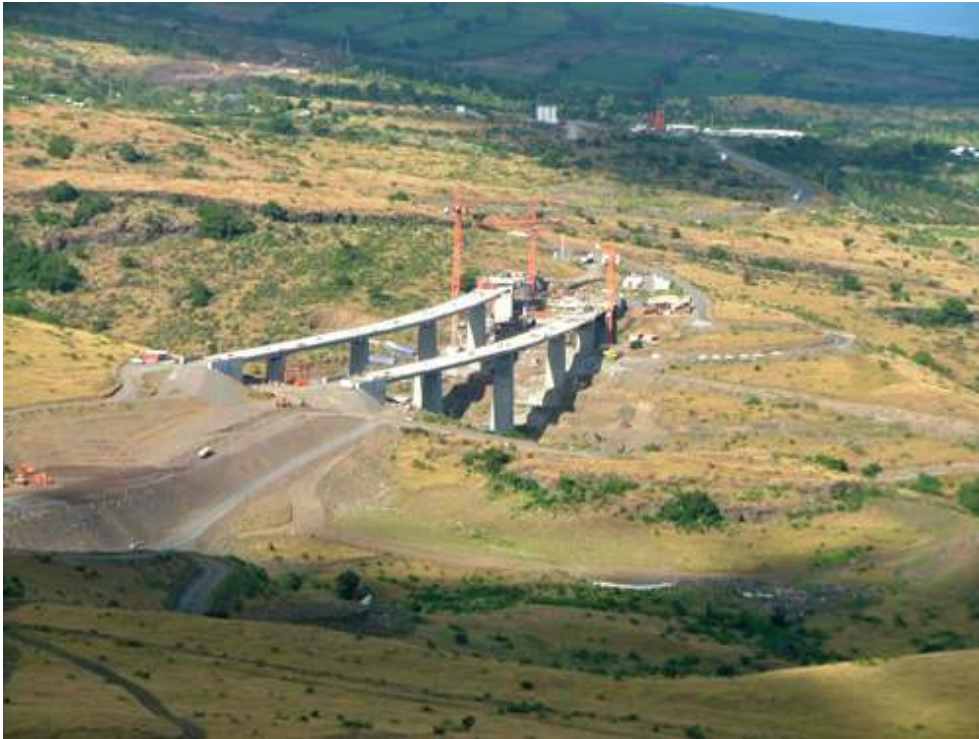
Figure 6 – Le viaduc de Fleurimont, dans les « hauts » de Saint-Gilles
