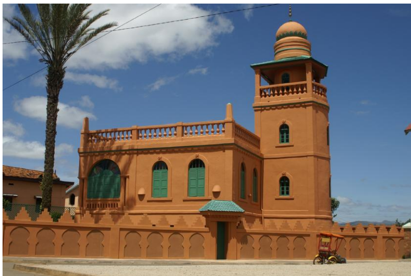
La mosquée d'Antsirabe en 2007 (photo Fr. Garan).
