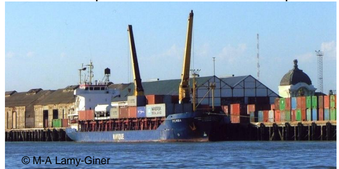
Vue sur une partie du terminal à conteneurs de Maputo
