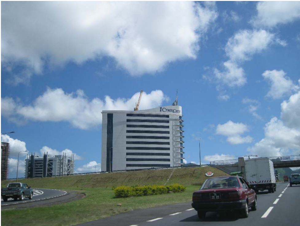
Figure 5 : Cyber-cité en construction, en bordure de la voie rapide reliant l'aéroport à Port Louis
