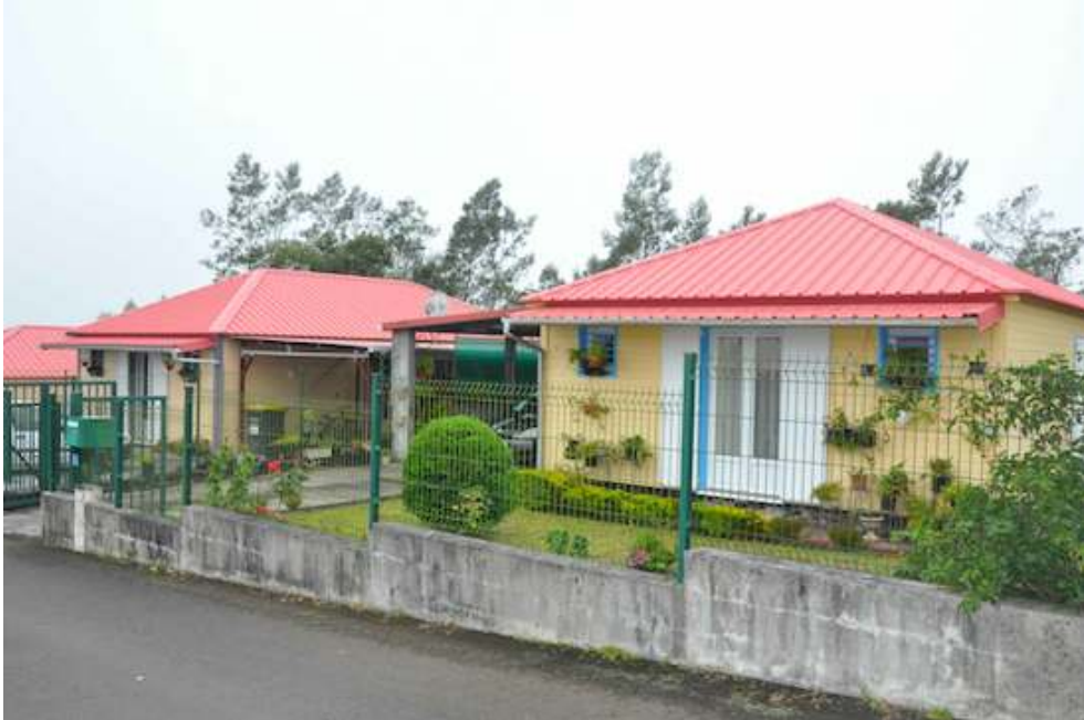
Figure 11. Logements sociaux individuels et groupés
