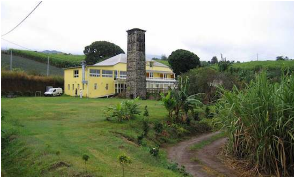
Figure 7. Auberge de campagne au Grand Tampon 4
