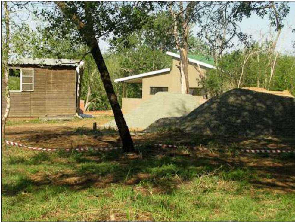
Illustration 7b – Le Nswelweni Bush Lodge en construction en 2009
